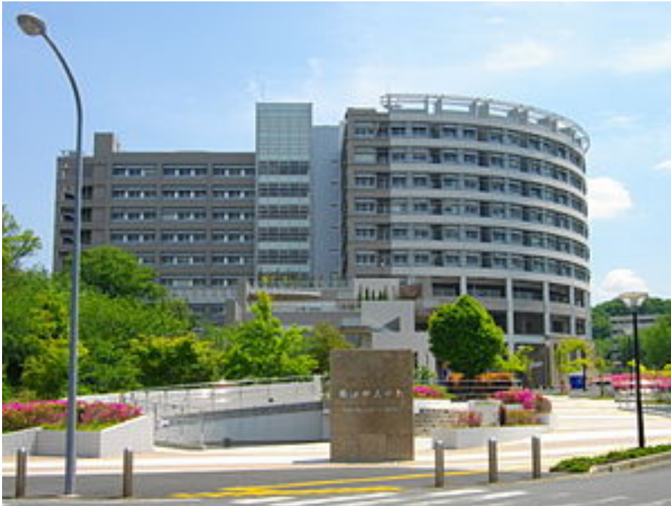
君津中央病院(正面より)
